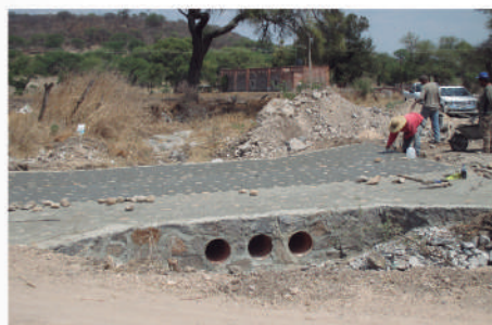
Construcción de vado en Los Portales
