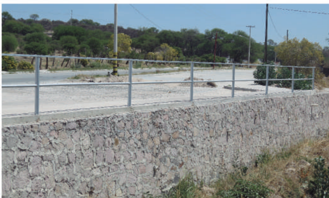
Mamposteo y banquetas en Libramiento Juan Pablo II
