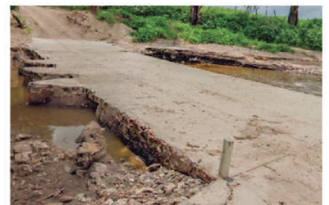
Construcción de vado en San Francisco
