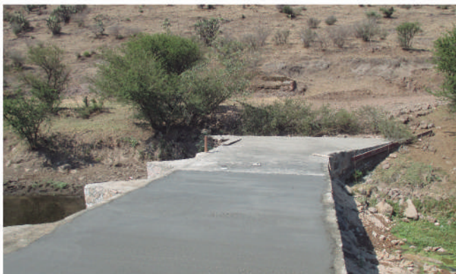
Construcción de vado en El Salto
